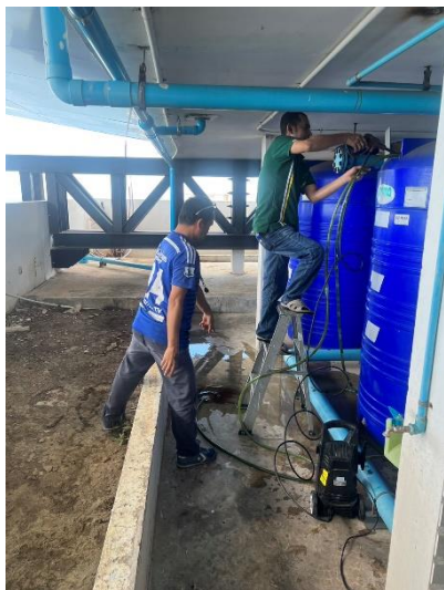
ภาพที่ 15 แสดงการล้างถังเก็บถังน้ำสำรองอาคาร
