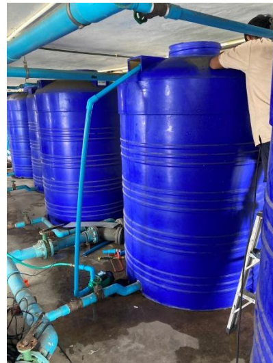
ภาพที่ 10 แสดงถังเก็บน้ำสำรองคาตฟ้า
