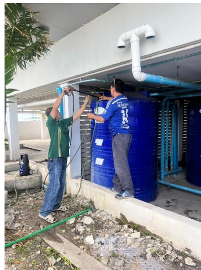
ภาพที่ 16 แสดงการล้างถังเก็บถังน้ำสำรองอาคาร
