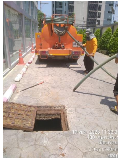
ภาพที่ 8 แสดงการสูบน้ำจากบ่อน้ำบาดน้ำเสีย
