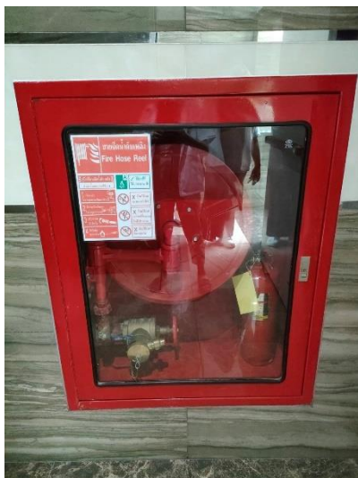
ภาพที่ 35 แสดงตู้ดับเพลิง (Fire Hose Cabinet)
