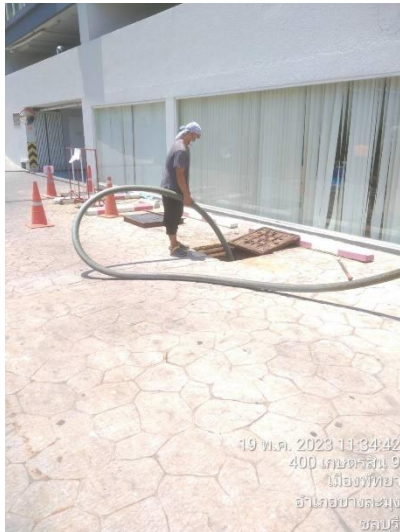
ภาพที่ 7 แสดงการสูบน้ำจากบ่อน้ำบาดน้ำเสีย
